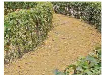
Teglsti : Stien, der binder bebyggelsen sammen med resten af områdets stier, er en sti af knust gul genbrugstegl, for at referere til områdets historie og for at understrege den bæredygtige profil.
