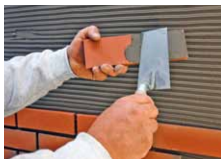
StoSilt Cera Tegl klæbes direkte på grundpuds og fuges
